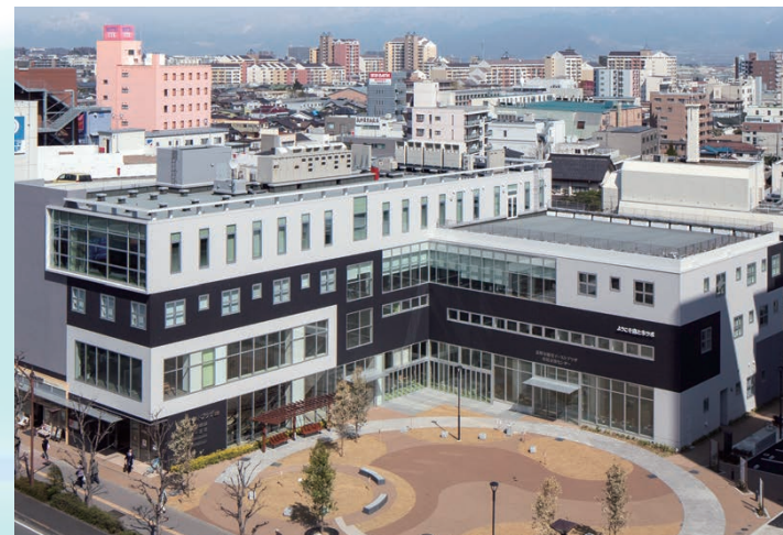
▲ 北棟全景（南西側から望む）
