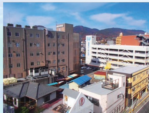
▲ 従前の様子（南東側から望む）
