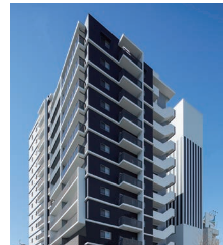
▲ 南棟全景（北東側から望む）
